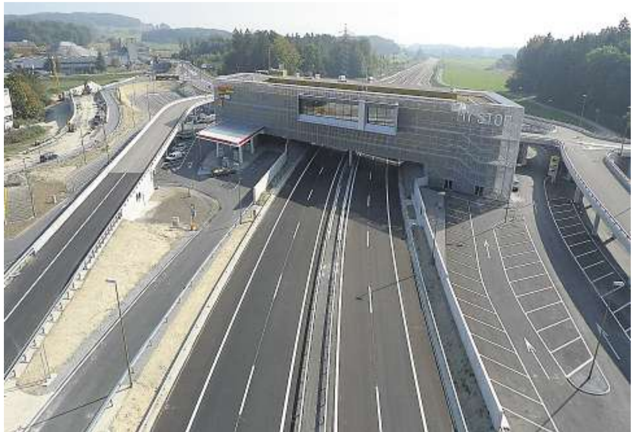
Imposante Anlage: Beim Autobahnanschluss Affoltern am Albis – dem einzigen im ganzen Knonaueramt – wird gleichzeitig mit der Autobahn auch eine moderne Raststätte mit Einkaufszentrum eröffnet. Bild Geri Holdener
